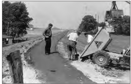
Deichbau zwischen Fährhaus Meyer und dem Wasserweg (Fertigstellung mit Asphaltdecke 1969)
