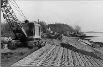
Deichbau zwischen Fährhaus Meyer und dem Wasserweg (Fertigstellung mit Asphaltdecke 1969)
