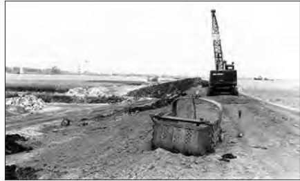
Deichbau 1963, nördlich vom Bunker „Valentin“
