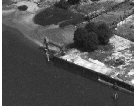
Luftaufnahme vom Farger Weserufer bei der Witteburg vom 8. Juni 1929 (Ausschnitt). In Übereinstimmung mit der Skizze (Abb. 7) erkennt man das auf einem Gerüst stehende Pegelhäuschen sowie die Brücke, die es mit dem Bollwerk verbindet. Quelle: Staatsarchiv Bremen, StAB 10.B FS 30 62-004.
