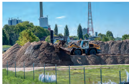
Jede Menge Erdaushub wird zwischengelagert
