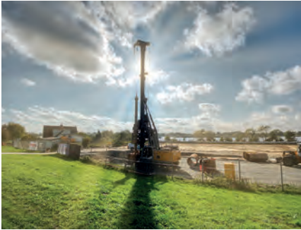
Drehbohrgerät LB 24 für den Erdaushub
