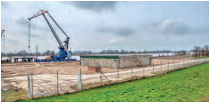
Rohrbrücken und kleinere Gebäude sind schon gewichen
