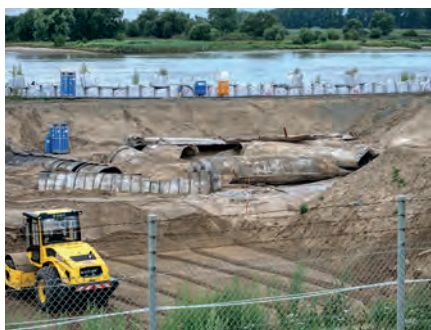
Alte Metalltanks werden ausgegraben
