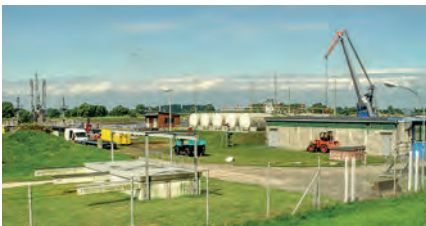
Beginn des Rückbaus
