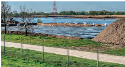
Fläche für kontaminierten Bodenaushub wird mit Folie abgedichtet
