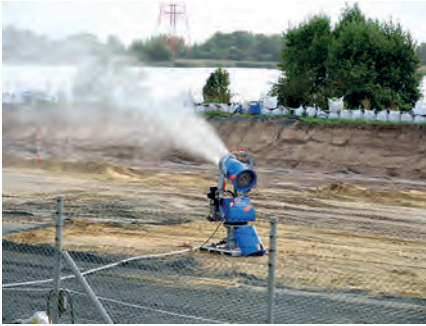
Schneekanone nicht für das Matterhorn, sondern gegen den entstehenden Staub in der Baugrube
