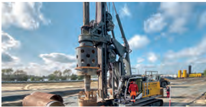
Drehbohrgerät LB 24 hat Verstärkung bekommen
