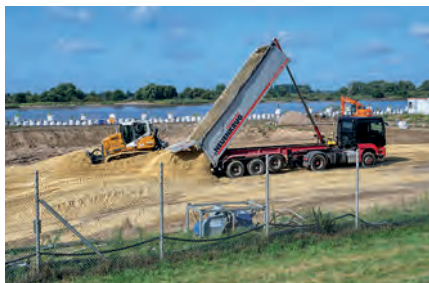
Baugrube wird verfüllt
