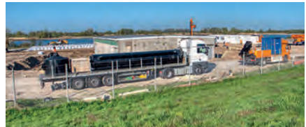
Erster Filter (von vier) für das kontaminierte Grundwasser wird angeliefert
