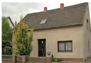
1988 Außenfassade isoliert und neu verputzt, Foto: 2020
