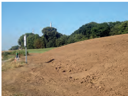
Foto: Zientek, HVFR - Deicherhöhung zwischen Fährhaus Farge und Wasserweg
