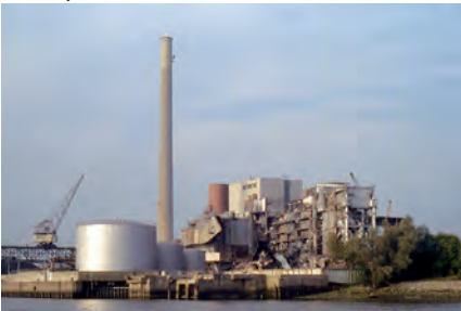
Kraftwerk Farge 1990 mit Rauchgasentschwefelungsanlage, [3]
