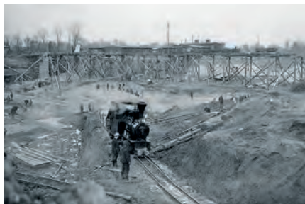
Bau des Kraftwerks von 1922 bis 1924. Erste Erdarbeiten
