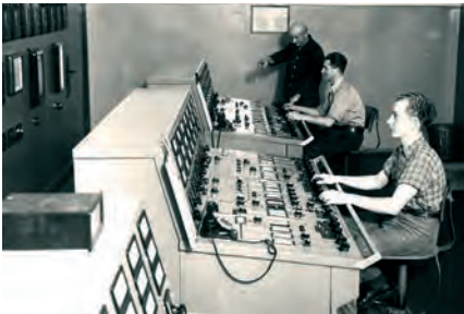
Wärmewarte für die Kessel 15/16/17 zu Beginn der 50er Jahre
