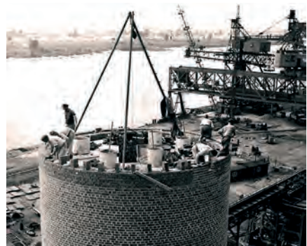
Bau eines neuen Schornsteins
