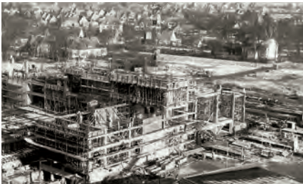
Bauarbeiten Block I 1967
