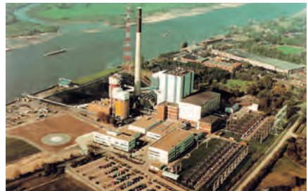
Kraftwerk Farge 1990 mit Rauchgasentschwefelungsanlage, [3]
