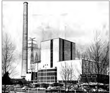
Der 320 MW Block 1 des Kraftwerk Farge
