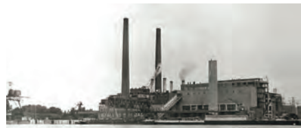
Dritter Schornstein bei der Erweiterung des Kraftwerks 1951
