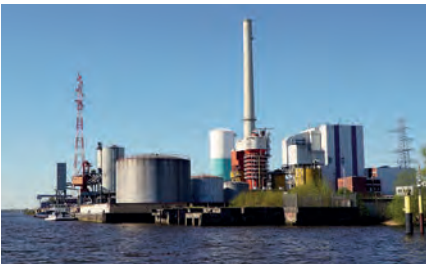
Das Kraftwerk Farge 2022
