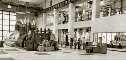
Der neue 70 MW Hochdruck-Kondensations-Turbosatz Nr. VII
